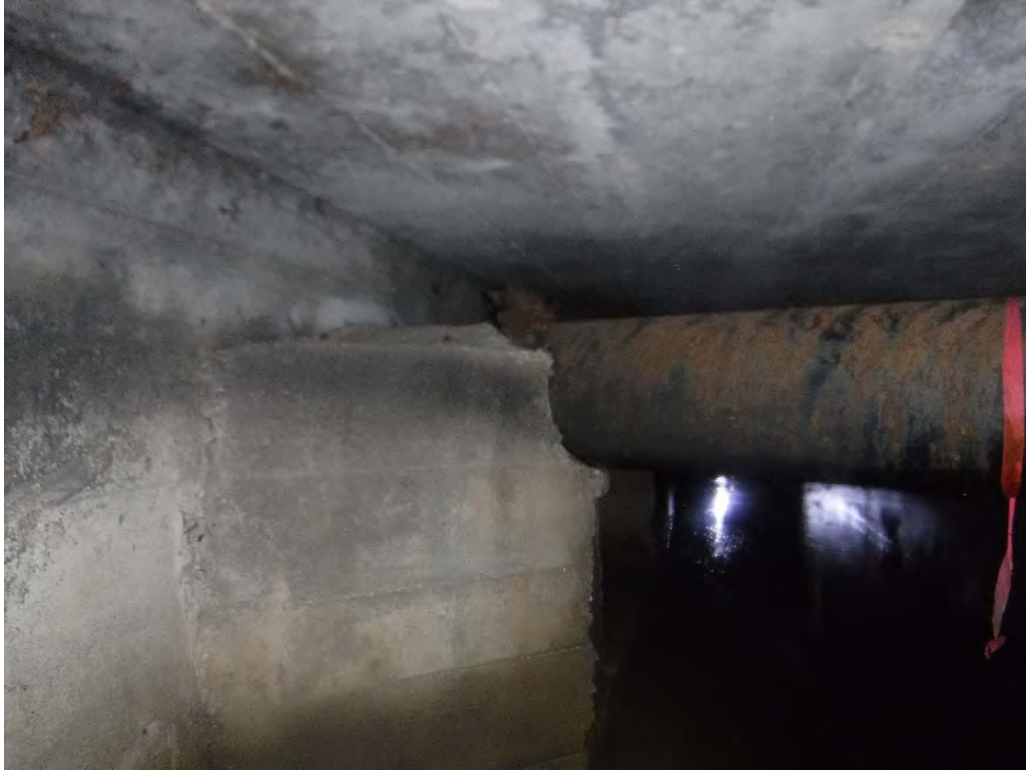
Figure 5 – STA. 10+13, 12" DI Sanitary Sewer.
