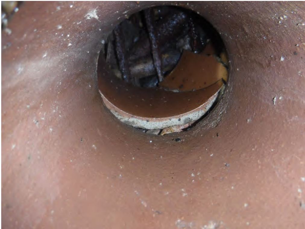
Figure 70 - STA. 20+63 6" clay tile.
