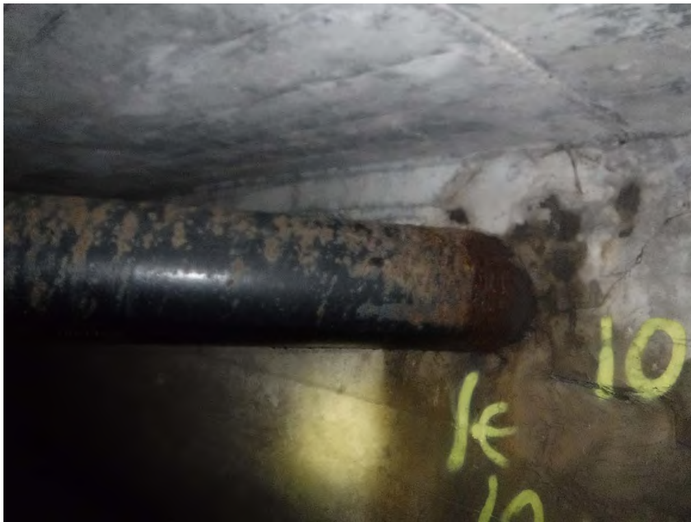
Figure 4 – STA. 10+11, 12" DI Sanitary Sewer.
