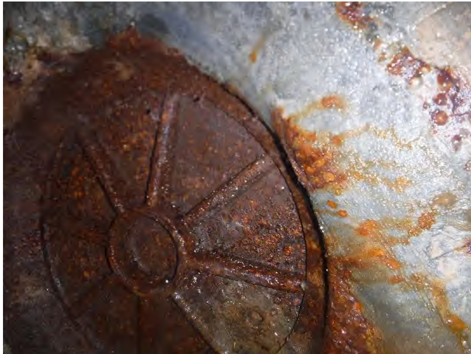
Figure 35 - STA. 17+50, sealed manhole.
