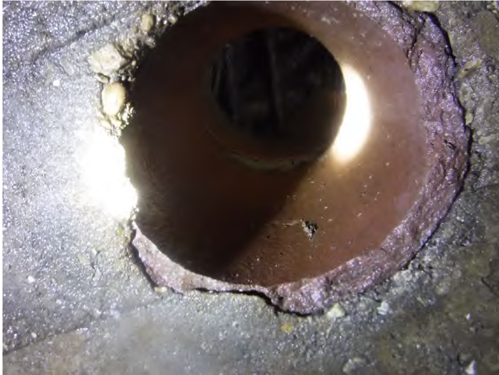
Figure 71 -STA. 20+63 6" clay tile.
